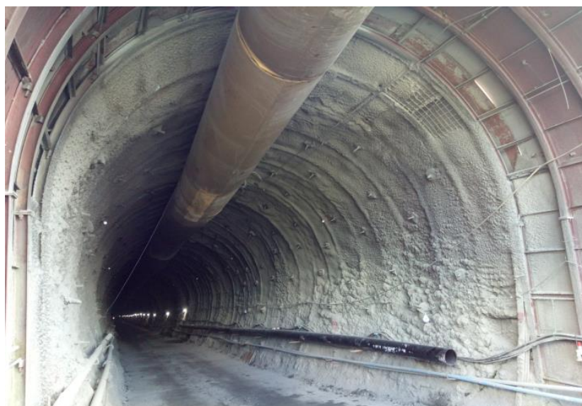
อุโมงค์ที่ขุดเจาะและติดตั้งค้ำยันอุโมงค์
