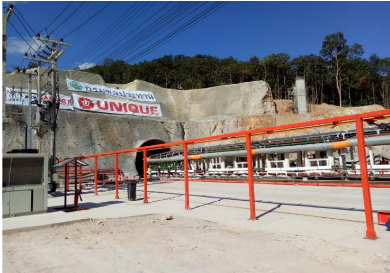
สายพานลำเลียงอุปกรณ์และห้องควบคุมการทำงาน
