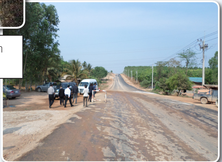
รูปที่ 2 ถนนลาดยางพร้อมไฟฟ้าของโครงการอ่างเก็บน้ำ นฤปดินทรจินดา (โครงการห้วยโสมง) จังหวัดปราจีนบุรี
